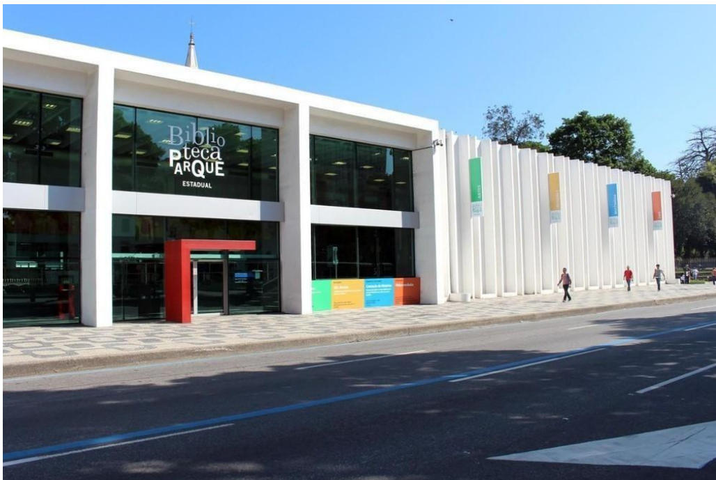
Biblioteca Parque Estadual • Centro • Rio de Janeiro Laboratório 2
